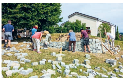
Bau der Trockenmauer
